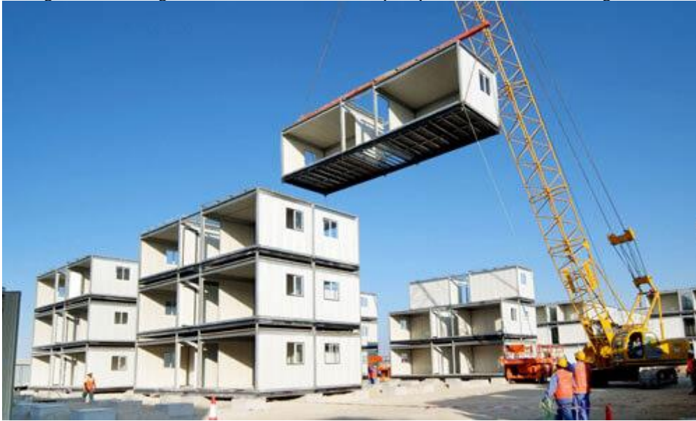
Figura 5 – Montagem in loco da CM com múltiplos pavimentos, com uso de guindaste
