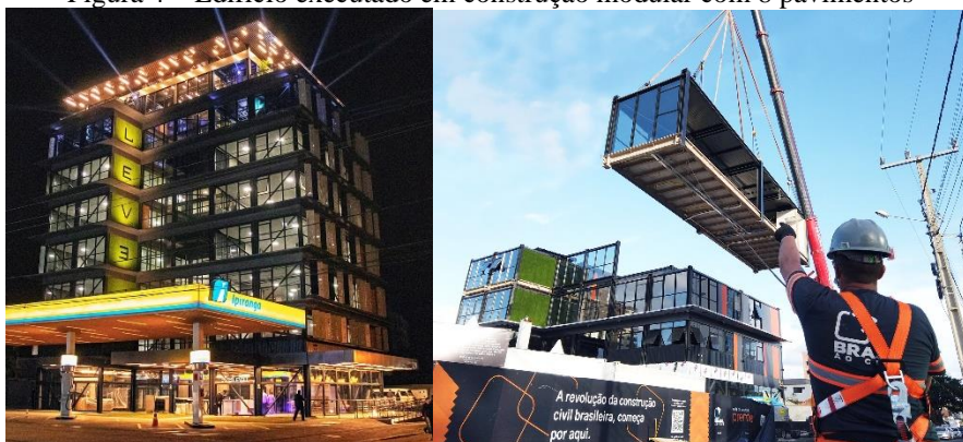
Figura 4 – Edifício executado em construção modular com 8 pavimentos
