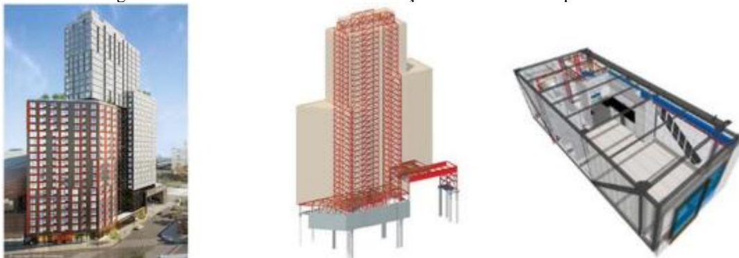
Figura 3 – Edifício executado em construção modular com 32 pavimentos
