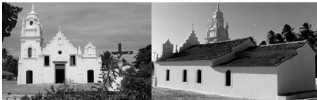
Figura 11 – Vista frontal e lateral da igreja após manutenção de 2005.
