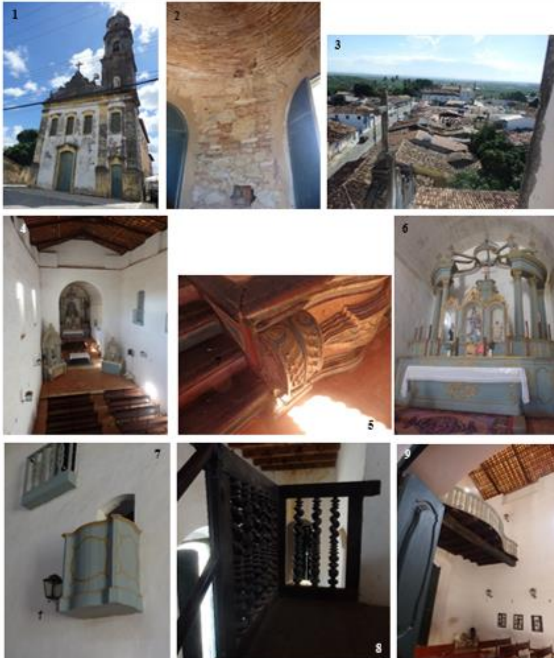
Figura 1: (1)- Fachada principal da Igreja de N. S a do Amparo dos Homens Pardos; (2)- Alvenaria mista – Tijolos (cúpula) e pedras calcárias nas paredes com emboçamento a base de cal e argila vermelha; (3)- Cruz latina encimando o frontão, vista da janela da torre sineira; (4)- Capela-mor da Igreja vista do Coro; (5)- Ornatos do madeiramento de entrada do Altar-mor; (6)- Detalhe do Altar-mor; (7)- Vista externa do púlpito; (8)- Detalhe do gradil trabalhado em retorcimentos espiralados da parte interna do púlpito; (9)- Vista do coro (estrutura de madeira e balcão) da entrada do corredor lateral da nave principal.
