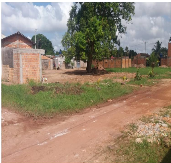
Figura 3 – Rua Amazonas, bairro do Tapanã
