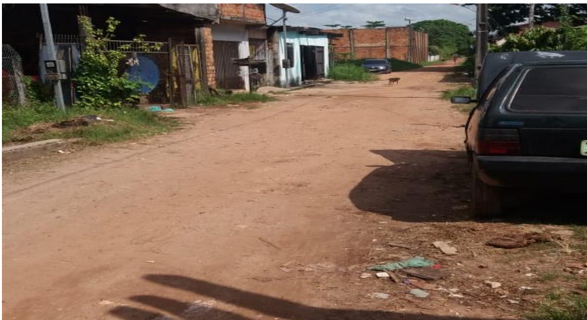
Figura 6 – Rua sem pavimentação
