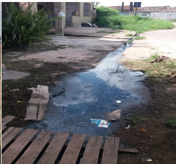
Figura 4 – Falta de escoamento de água
