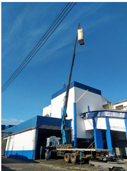
Figura 9 -Transferência dos painéis para o piso superior
