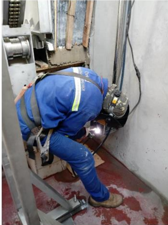
Figura 12 -Solda TIG em eletrodutos em aço inox 304
