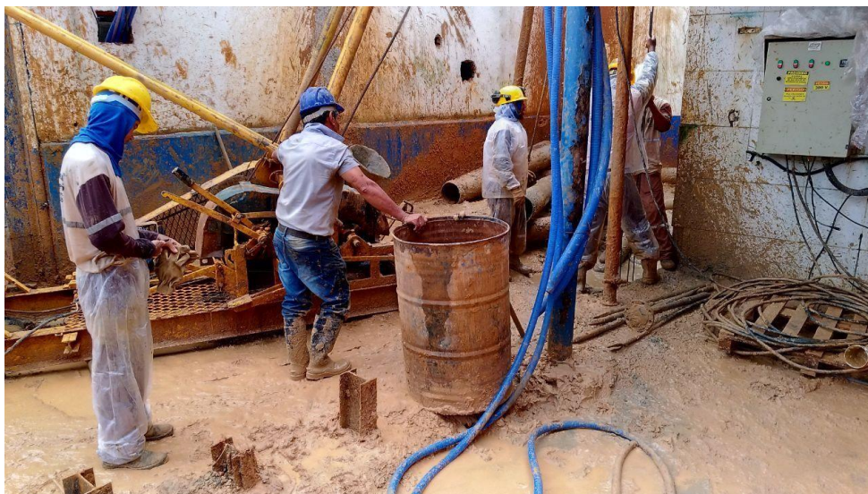
Figura 8 - Início da fundação para as bases de concreto
