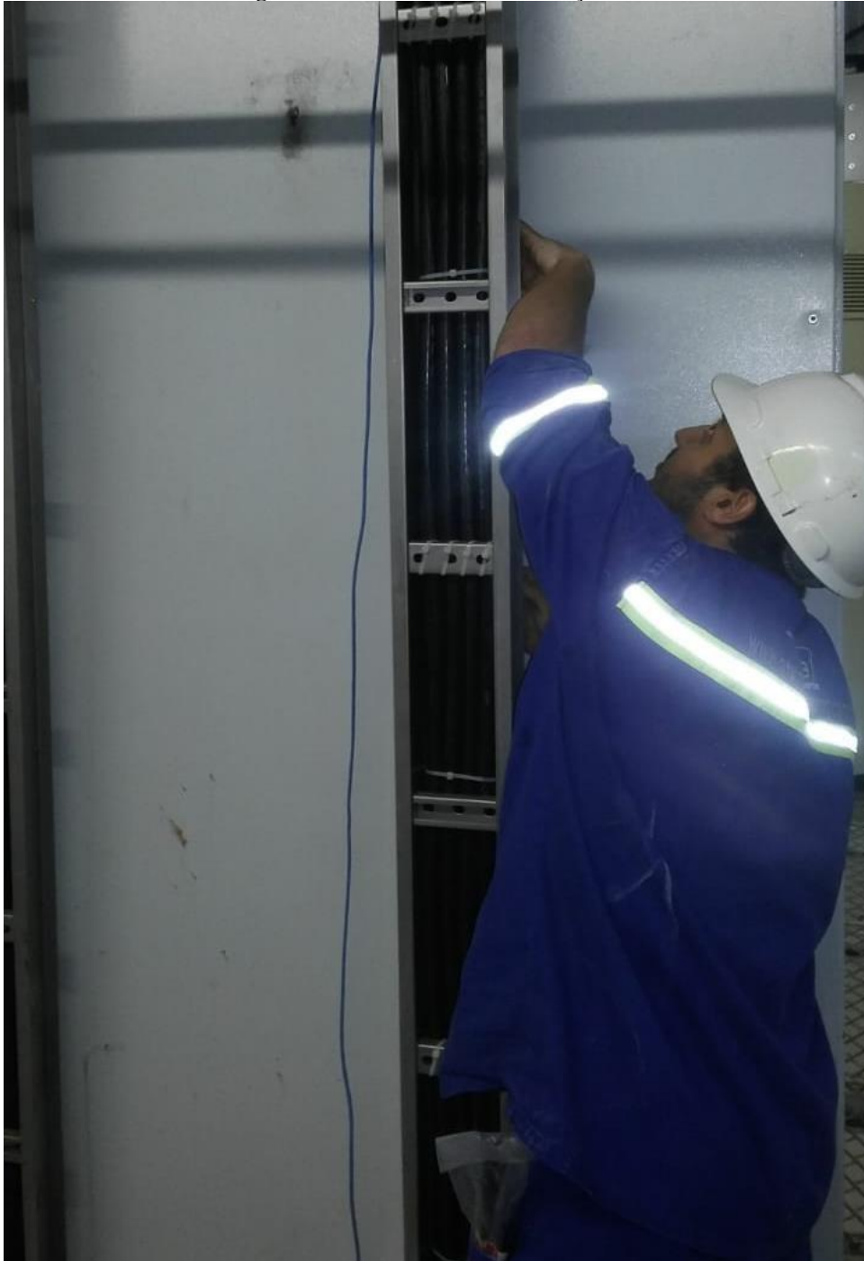
Figura 17- Acabamento nas instalações
