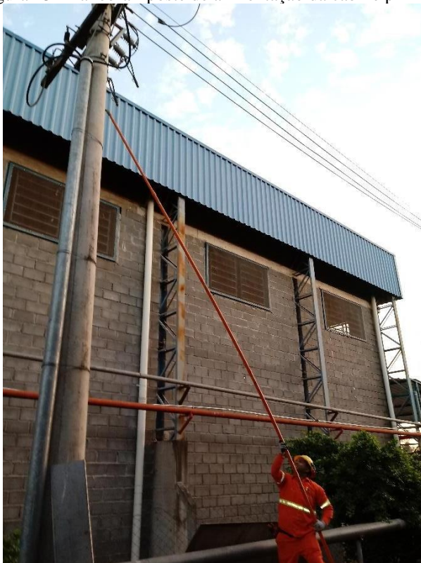
Figura 13- Manobra - poste de alimentação da cabine primária
