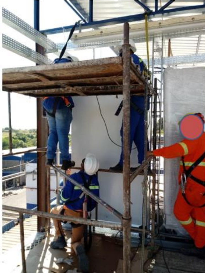
Figura 11 Início da montagem de eletrocalhas
