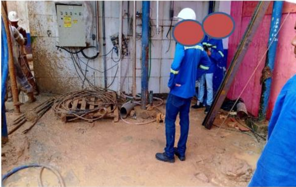
Figura 7- Preparação do terreno para fundações
