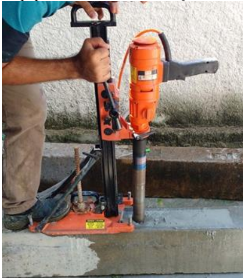
Figura 7: Equipamento utilizado na extração dos testemunhos
