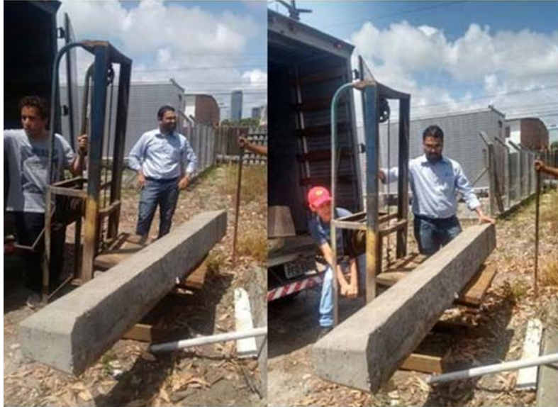
Figura 5: Remoção e acomodação dos dormentes no caminhão
