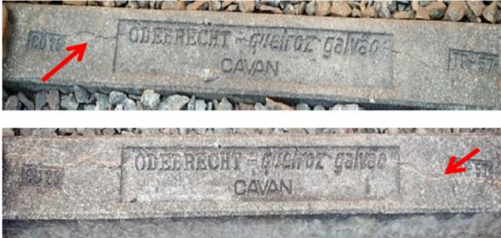
Figura 3: Face superior fissurada
