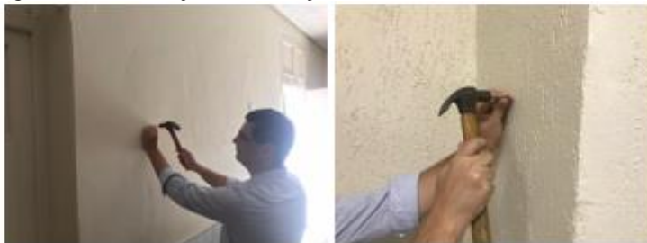
Figura 2: Identificação/confirmação de estruturas em concreto armado
