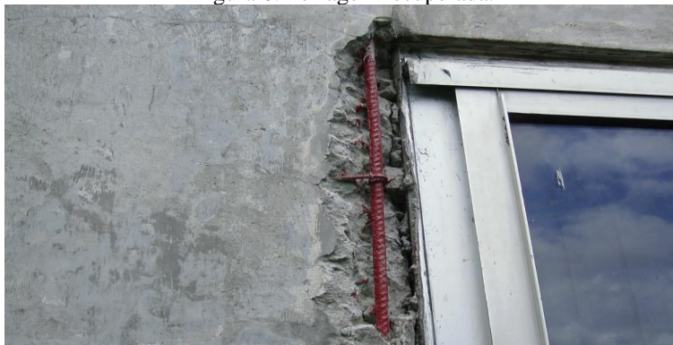
Figura 6: Ferragem recuperada.
