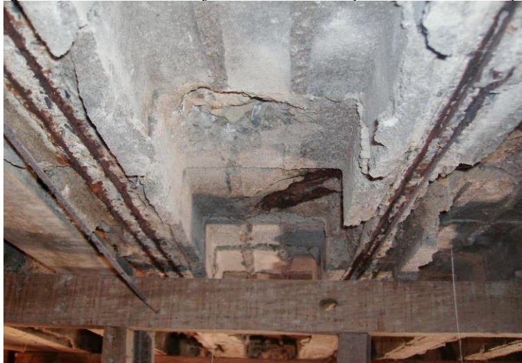
Figura 5: Escoramento de laje deteriorada do 1º pavimento da edificação.
