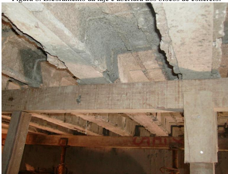
Figura 8: Escoramento da laje e abertura dos blocos de concreto.
