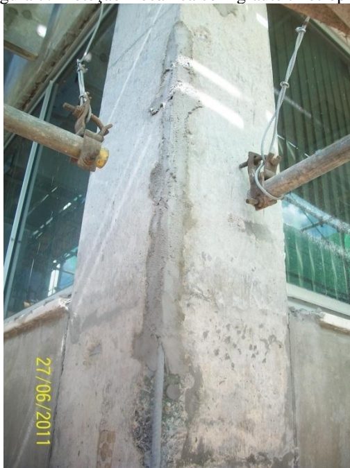
Figura 7: Proteção mecânica com graute tixotrópico.
