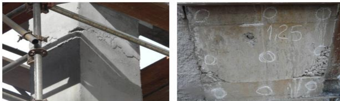
Figura 5: Detalhe da junta de concretagem de algum dos pilares analisados.
