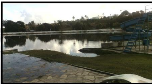
Figura 2: Vista Frontal do Balneário do Santa Rita – PB, 2018.
