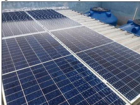
Fig. 3 – Sombreamento parcial nos módulos
