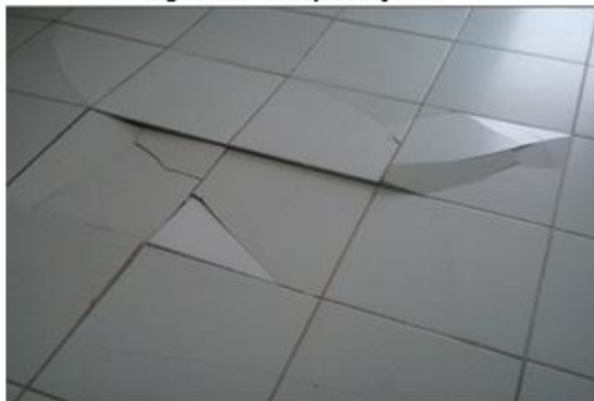
Figura 7 – Elevação de pisos.
