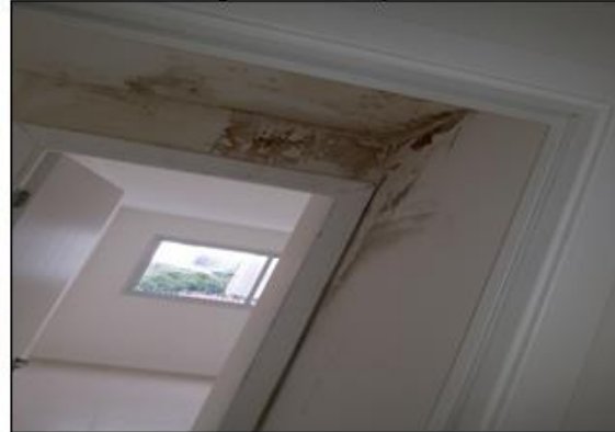
Figura 6 – Infiltração
