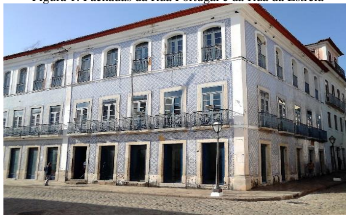
Figura 1: Fachadas da Rua Portugal e da Rua da Estrela
