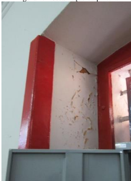
Figura 4: Descamação da pintura
