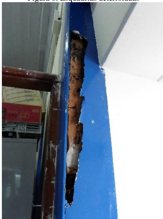
Figura 8: Esquadrias deterioradas
