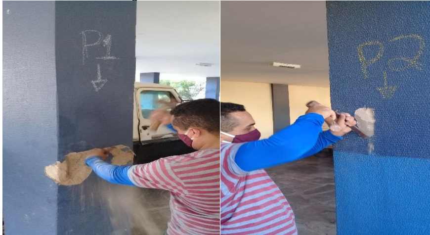
Figura 02 – retirada do revestimento.
