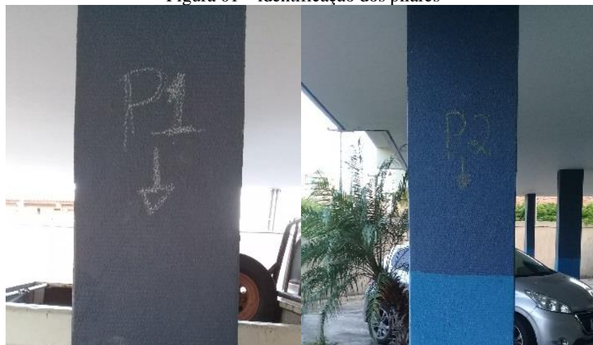
Figura 01 – identificação dos pilares
