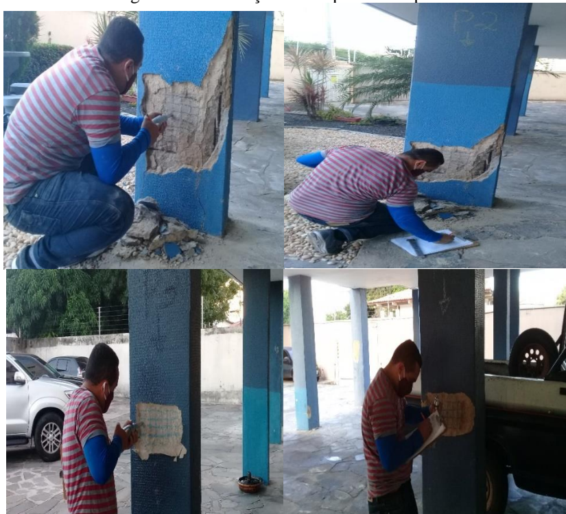
Figura 03 – realização dos impactos nos pilares
