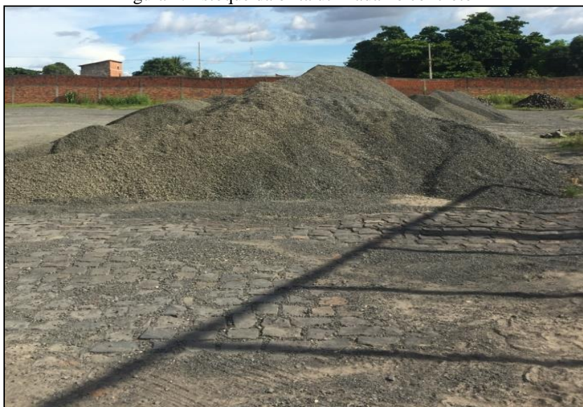
Figura 1: Estoque da brita utilizada no concreto
