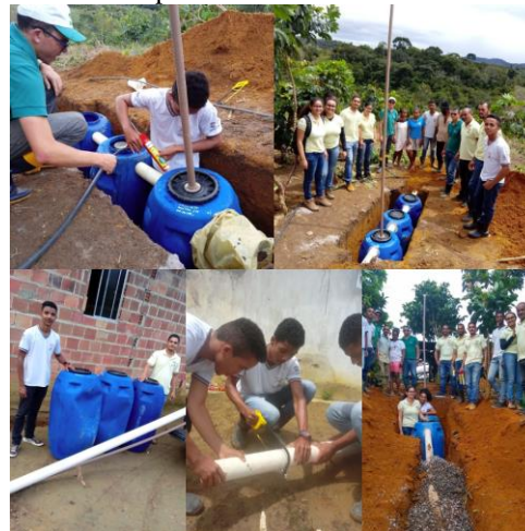
Figura 7. Implantação de Fossa Séptica nas Unidades Famílias beneficiadas
