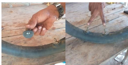
Figura 4- Acoplação da mangueira e do registro de água no tambor
