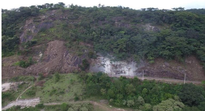
Figura 5: Vista aérea do local da obra.
