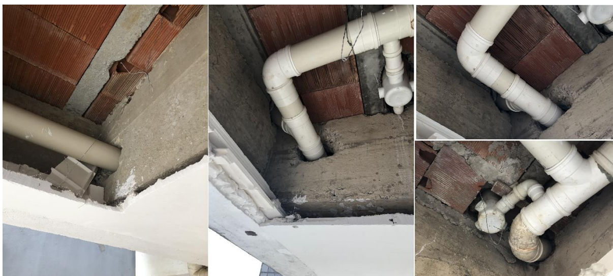
Figura 3 – Situação de furo não previsto em viga de concreto armado (Dos Autores, 2020).
