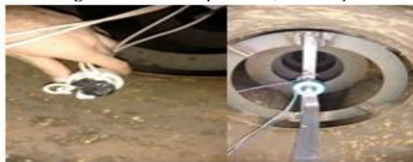
Figura 5. Conector queimado; e a solução.
