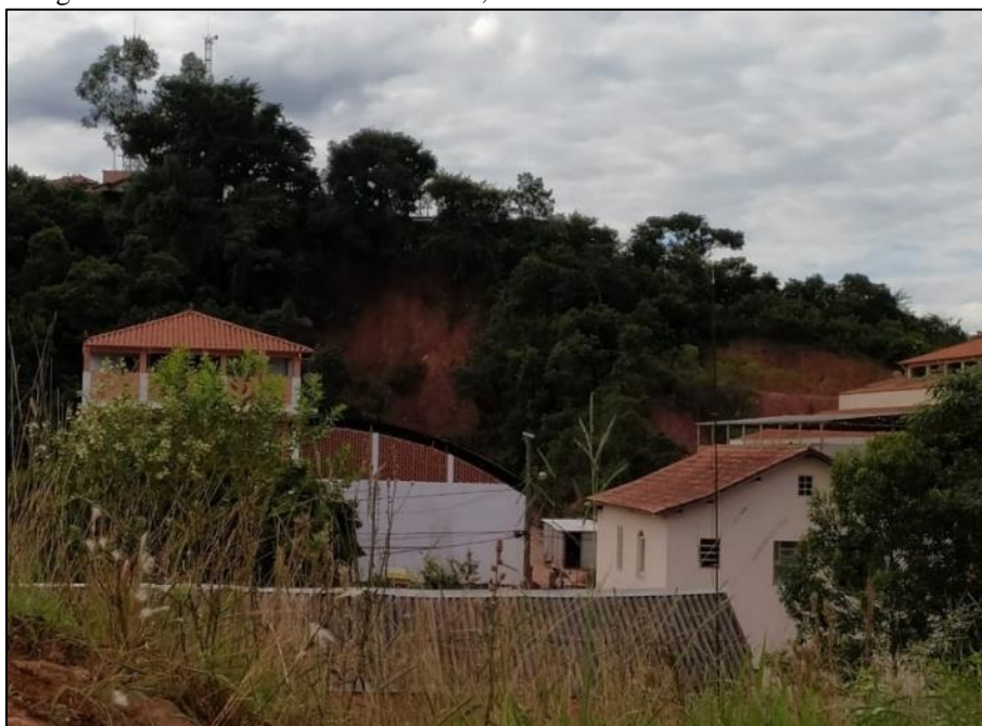
Figura 9 - Área de elevada declividade, contudo não classificadas como de risco.
