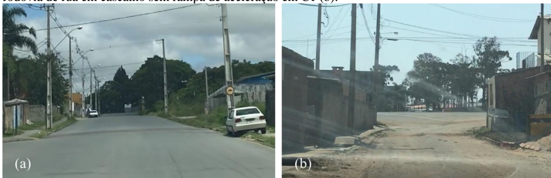
Figura 4: Detalhamento de ondulação e sinalização irregulares em C2 (a) e detalhamento de acesso à rodovia de rua em cascalho sem rampa de aceleração em C1 (b).
