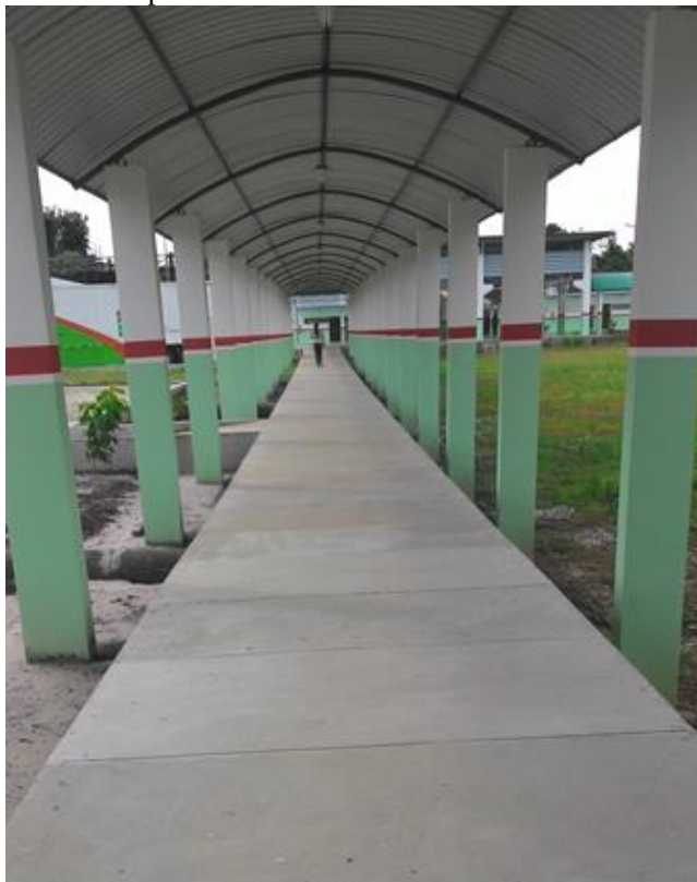
Figura 2. IFPA Campus Breves. Passarela de acesso aos blocos. IFPA, 2016.
