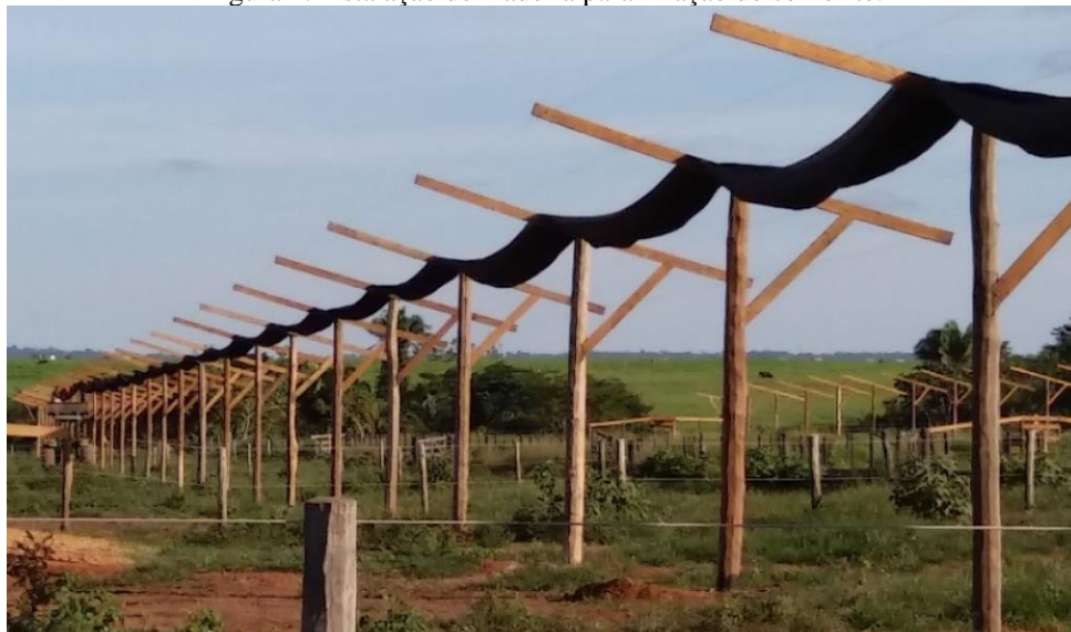
Figura 2: instalação de madeira para fixação do sombrite.
