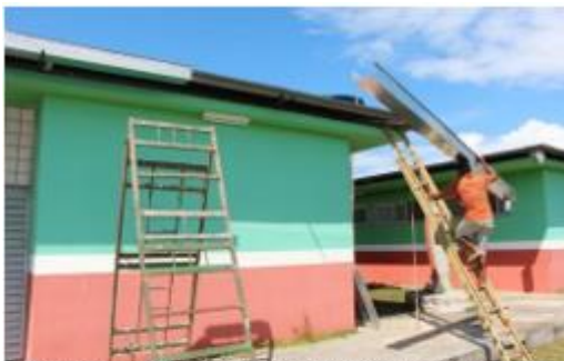
Montagem da calha horizontal de aço galvanizado
