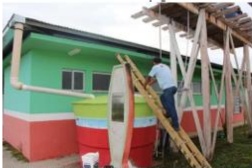
Instalação da bateria para armazenamento da energia
