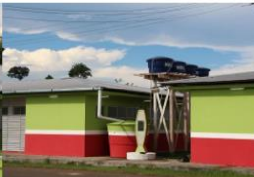
Iluminação externa da Residência do IFAM
