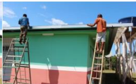
Montagem da calha horizontal de aço galvanizado
