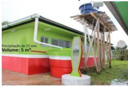
Reservatório completamente cheio após chuva de 25 mm
