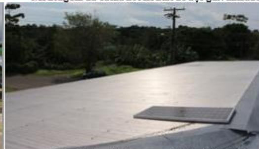
Painel fotovoltaico com potência de 135 W
