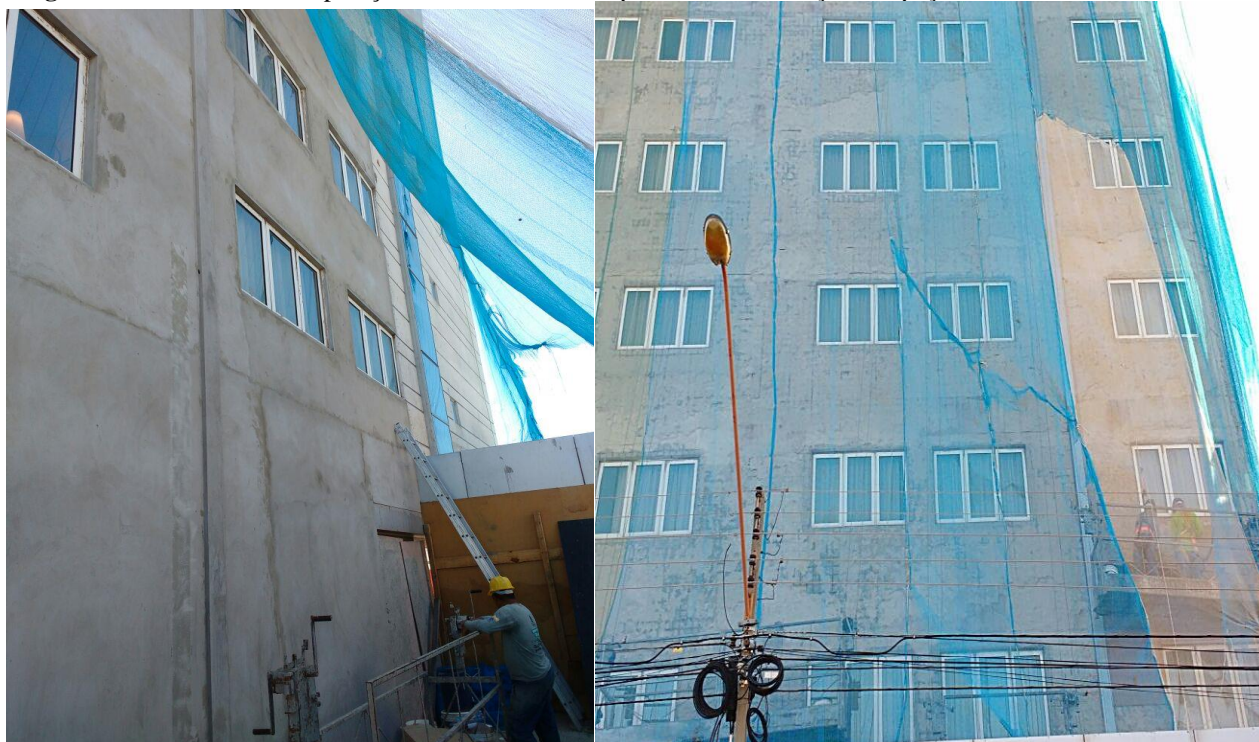
Figura 6 – Processo de recuperação da fachada voltada para o norte, remoção das peças cerâmicas do revestimento
