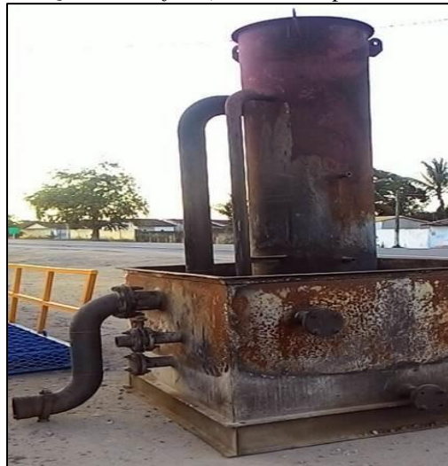
Figura 6: Queimador ( flare ) desafixado para manutenção.
