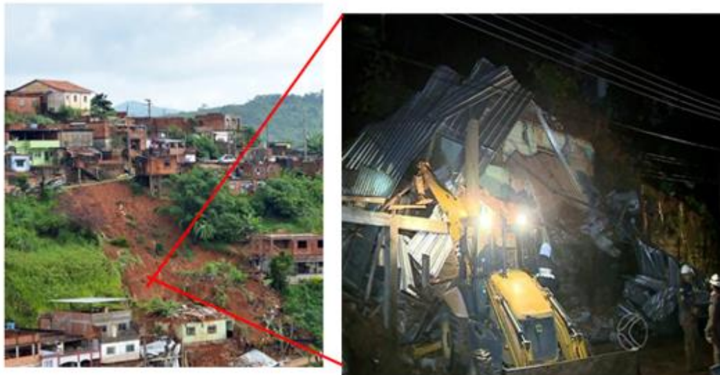
Figura 6: Movimento de massa no bairro Jardim Natal. A foto a esquerda mostra o escorregamento. À direita, um detalhamento da ação da Defesa Civil no local. Fonte: Tribuna de Minas (2013).
