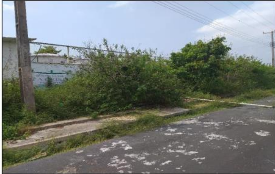
Figura 12 - Estação de Tratamento de Efluentes instalada no residencial Vila Cristina
