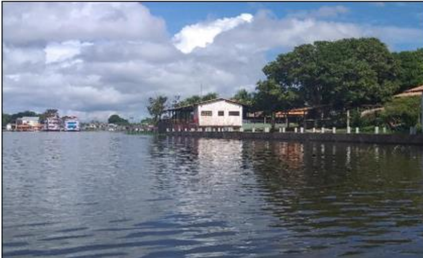
Figura 9 - Edificações no leito do lago.
