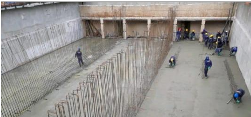
Figura 1 - Vista do piso concretado
