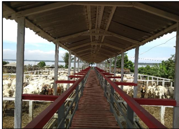
Figura 7 - Plataforma elevada no abatedouro 3.
