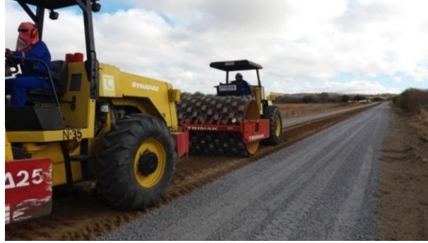
Figura 2 – Compactação da base
