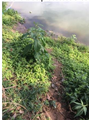
Figura 6. Incidência de processos erosivos no solo.
