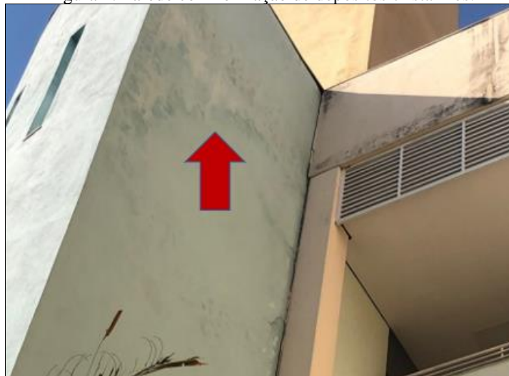
Figura 4: Parede com formação de depósitos cristalinos.
