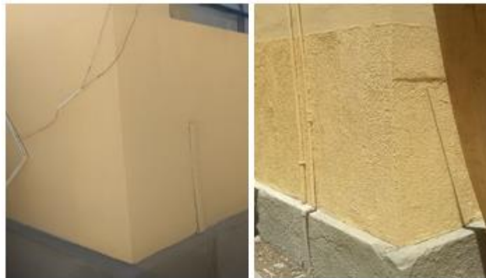
Figura 8: Pilar 1 e 2 recuperado
