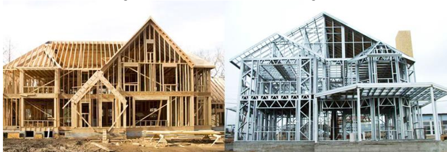
Imagem 1- Estruturas em Wood Framing e LSF
