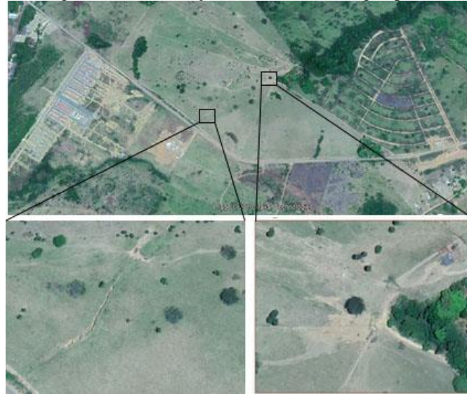
Figura 13. Visão geral- Local da voçoroca e nascente do igarapé Santana em 2017.
