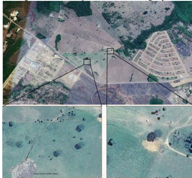
Figura 12. Visão geral- Local da voçoroca e nascente do igarapé Santana em 2016.
