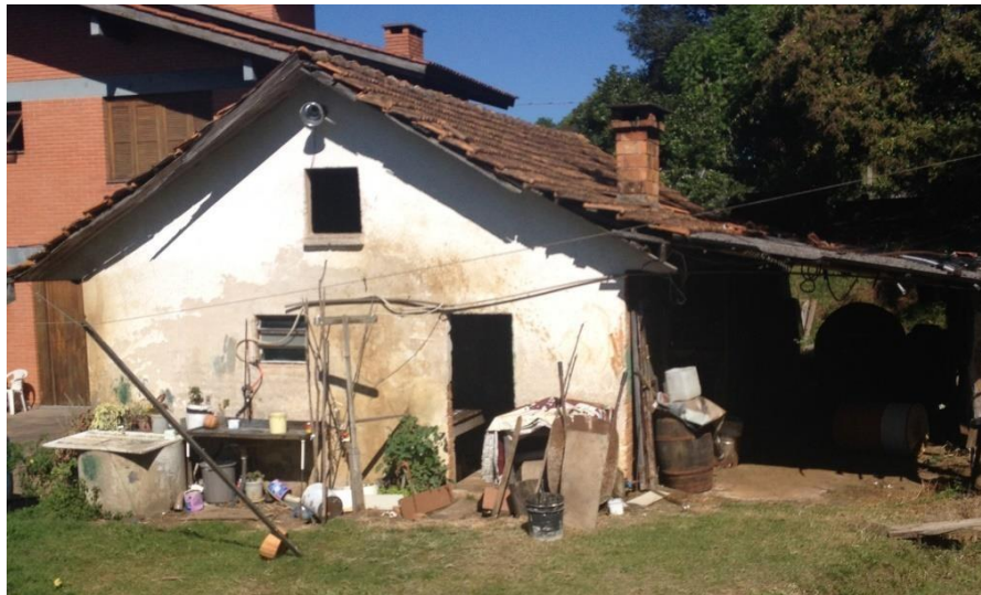
Figura 3 – Terceira Residência, utilizada apenas para o fogo
