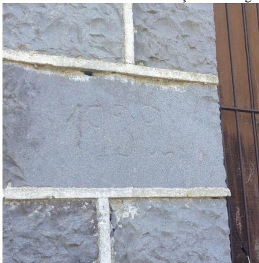
Figura 1a – Pedra com ano de construção da casa gravado
