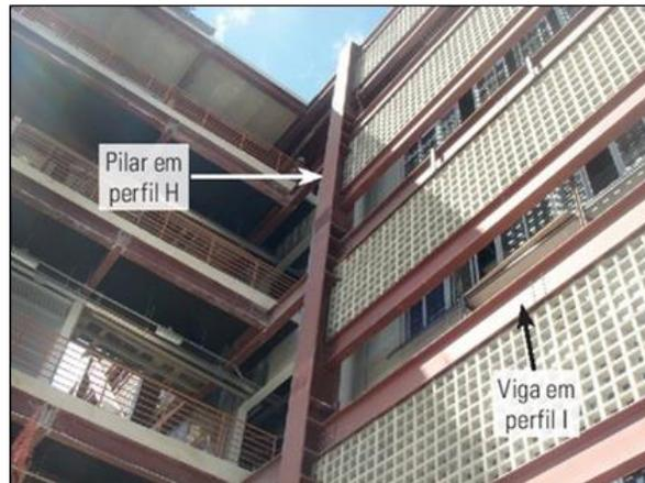
**Figura 2:** Ligação entre Vigas e Pilares. Fonte: Fakury *et al* (2016).
