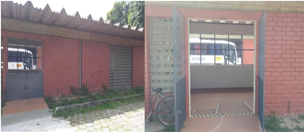
Figura 2 - Galpão de armazenamento
