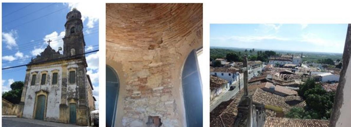
Figura 01: (esquerda) – Fachada principal da Igreja de N. S<sup>a</sup> do Amparo dos Homens Pardos; (centro) – Alvenaria mista – Tijolos (cúpula) e pedras calcárias nas paredes com emboçamento a base de cal e argila vermelha; (direita) – Cruz latina encimando o frontão vista da janela da torre sineira da Igreja de N. S<sup>a</sup> do Amparo dos Homens Pardos. Fonte: Eder Silva, mar. 2018.
