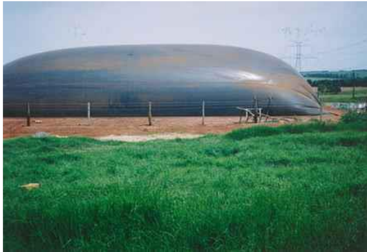
Figura 5: Biodigestor modelo canadense.
