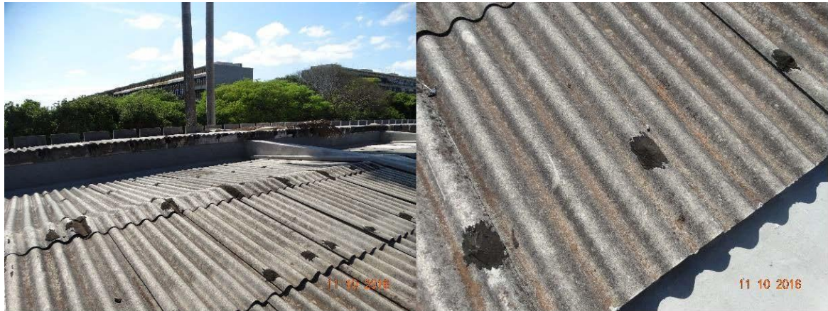
Figura 09 –Telhas localizadas na cobertura do edifício da Agência. (Fonte: autores)
