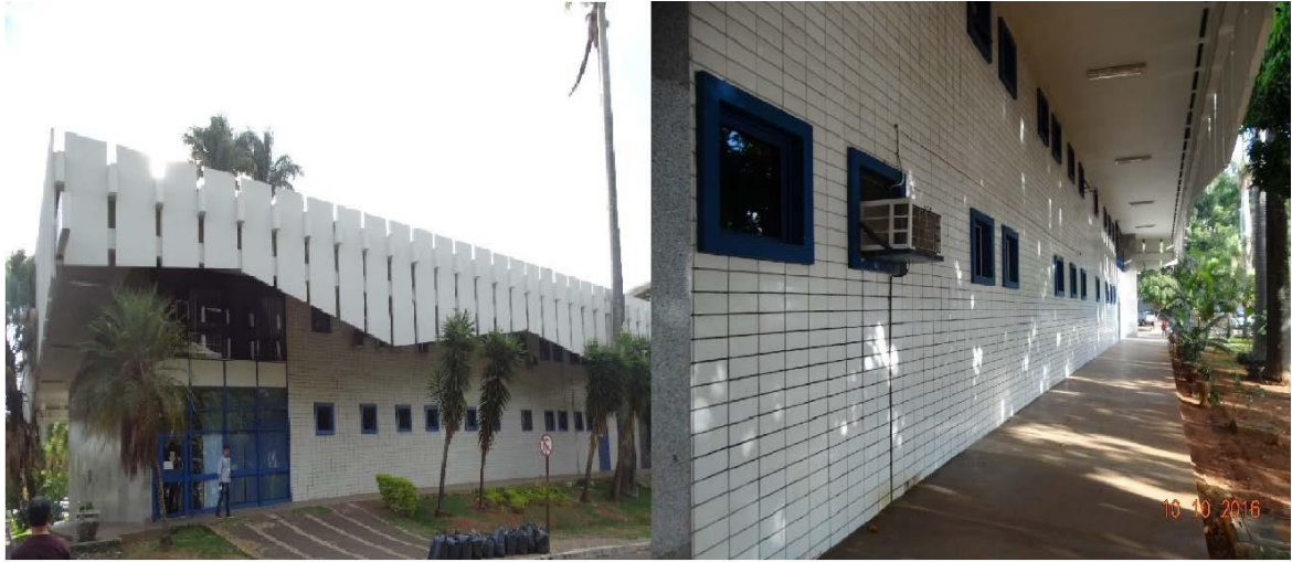
Figura 03 –Revestimento gail nas fachadas leste (esquerda) e oeste (direita). (Fonte: autores)
