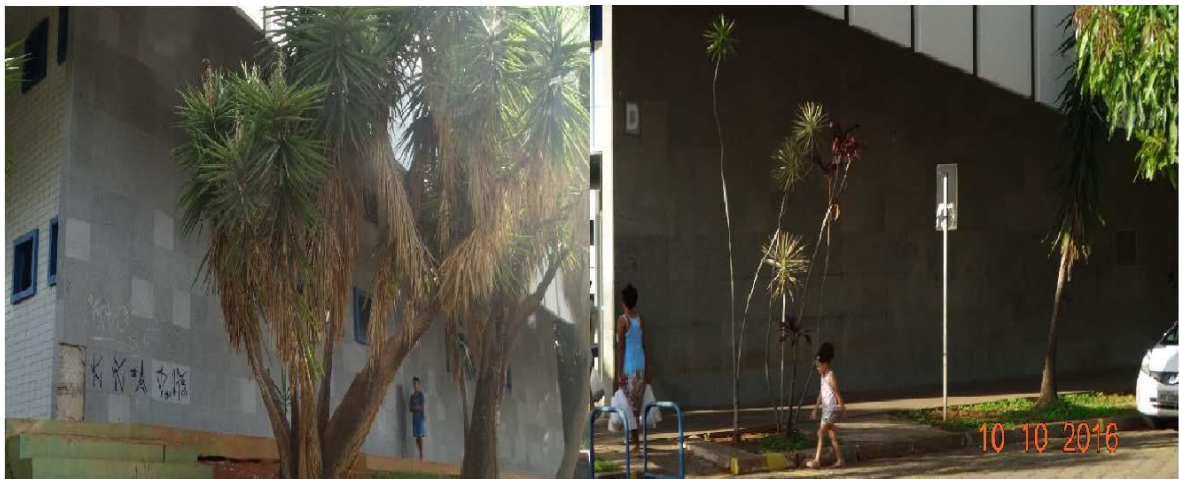
Figura 04 –Revestimento em granito nas fachadas norte (esquerda) e sul (direita) . (Fonte: autores)
