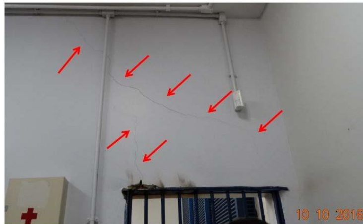
Figura 12 – Alvenaria externa acima da porta de segurança da sala do cofre. (Fonte: autores)
