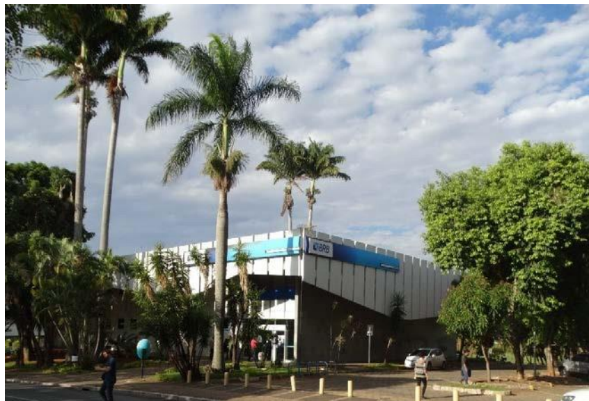
Figura 02 –Fachada frontal da Agência do Banco do Brasil. (Fonte: autores)
