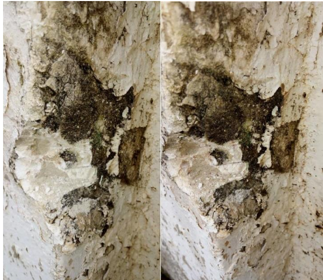
Figura 13 – P50 antes da aplicação da fenolftaleína (esquerda) e após aplicação (direita) . (Fonte: autores)
