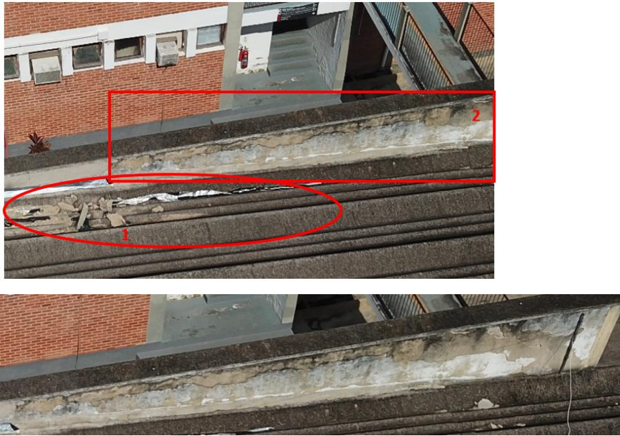
Figura 9 – Inspeção visual dos telhados
