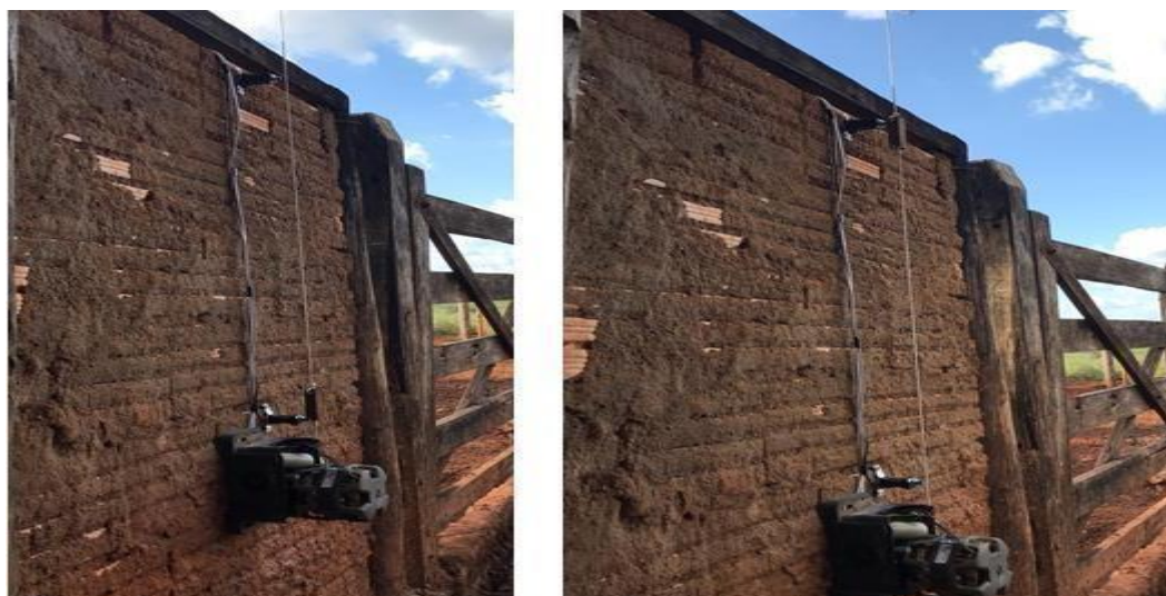
Figura 5 – Motor responsável pela abertura e fechamento da zona 1.
