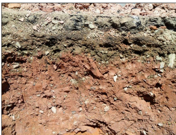
Figura 15 – Janela de Inspeção localizada na Estaca 30
