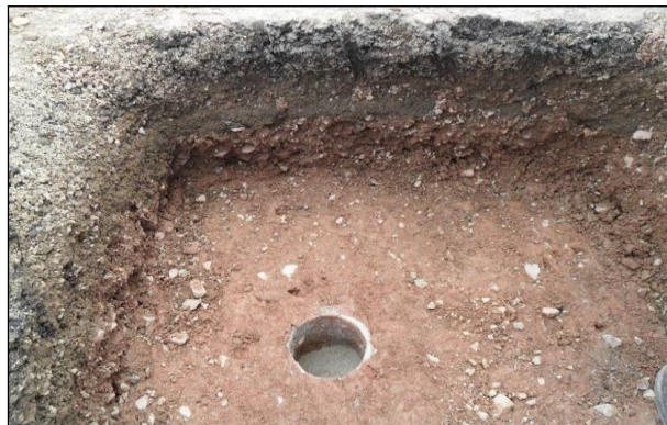
Figura 12 – Janela de Inspeção localizada na Estaca 09
