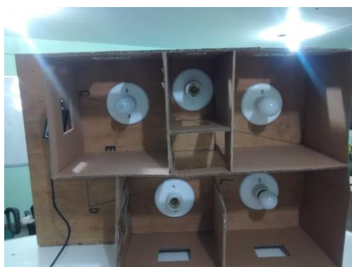
Figura 05: Vista dos bocais das lâmpadas e circuito elétrico.
