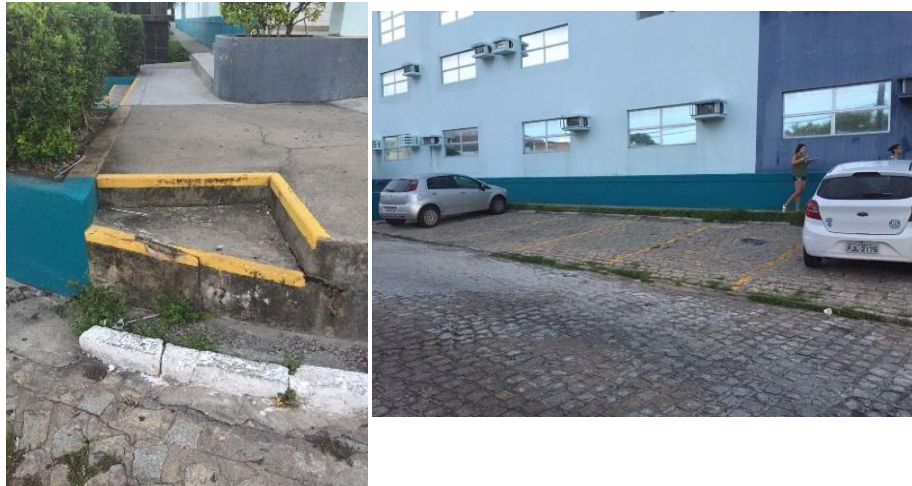
Figuras 4, 5 e 6: Levantamento fotográfico (alguns trechos).
