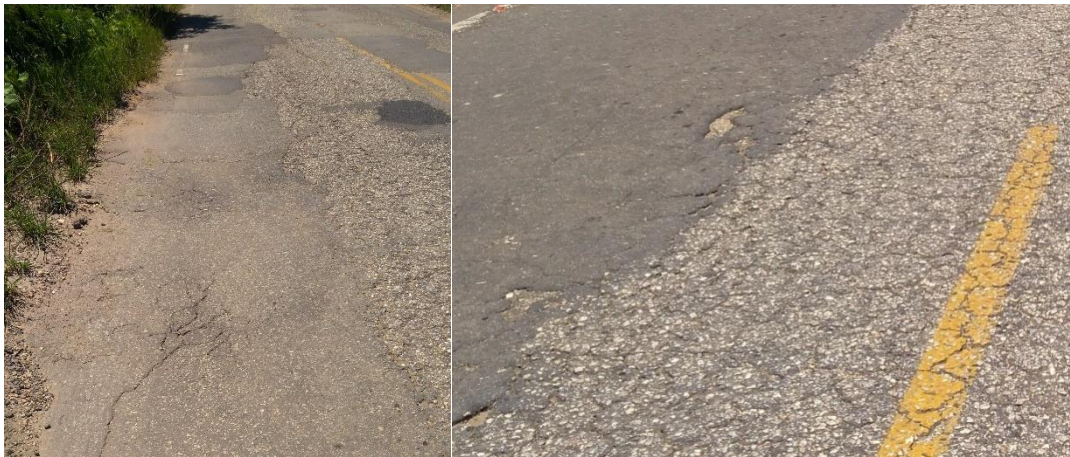
Figura 5. Desgaste de superfície encontrados na SE-065
